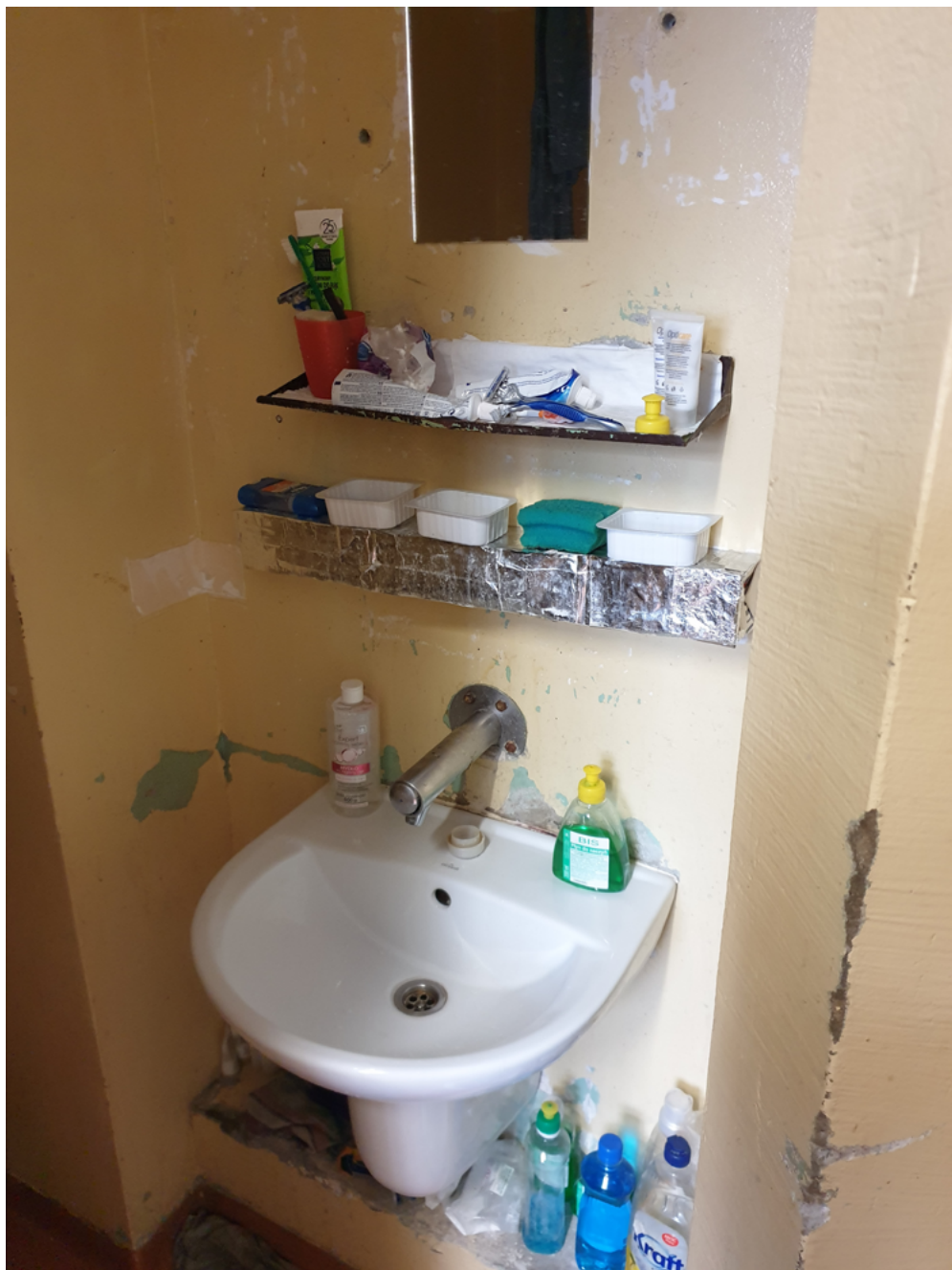
Areszt Śledczy Warszawa-Służewiec Toaleta w celi
