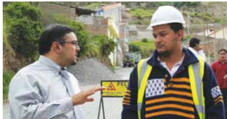
Recorrido de avances de obras para la construcción de nuevas unidades judiciales en la provincia de Chimborazo.
