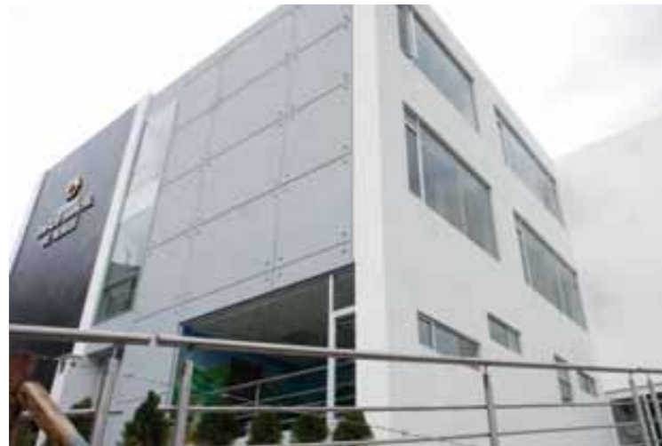
Edificio Judicial. Alausí, Chimborazo. Inauguración: 24 de septiembre de 2012.
